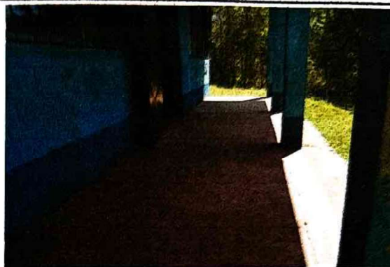
Foto 2: Sustitución de piso por Azulejo, corredor por deterioro.
